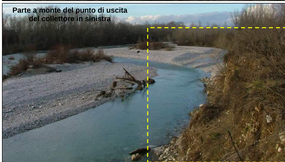
Scarpata di raccordo tra il piano di campagna ed i letto del T.Torre
