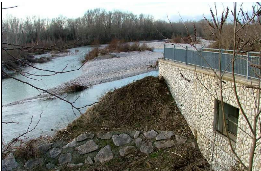
Alveo del T. Torre nei pressi dello sbocco della condotta di smaltimento delle acque meteoriche della zona industriale posta lungo la SP. n°48
