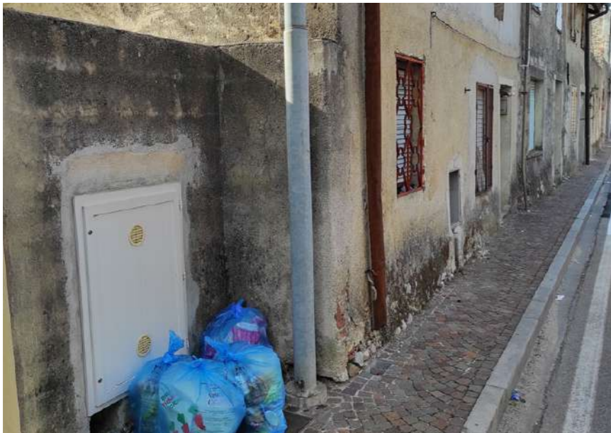
Marciapiedi insufficienti alla fruizione
