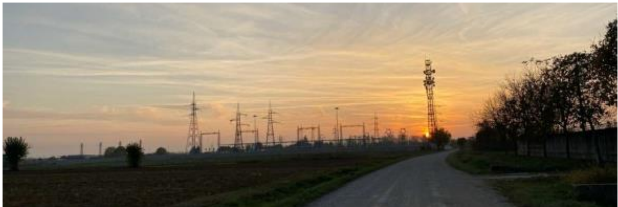
Elettrodotti lungo Strada di Ronchis, nei pressi del Cimitero di Remanzacco
