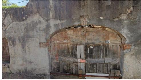
*edifici degradati in stato di rudere su via Ziracco, gli elementi del portale non sono più presenti, rimane solo il foro, i tetti sono crollati.*
